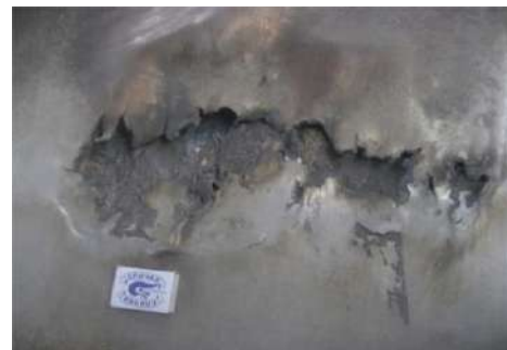
Рис. 3. Дефект биметалла: прожиг (свищ) поверхности плакирующего слоя
